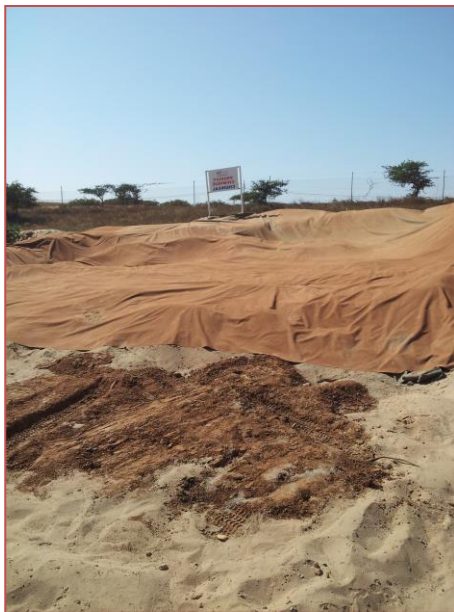
Photo II-4 : Confinement sols contaminés
