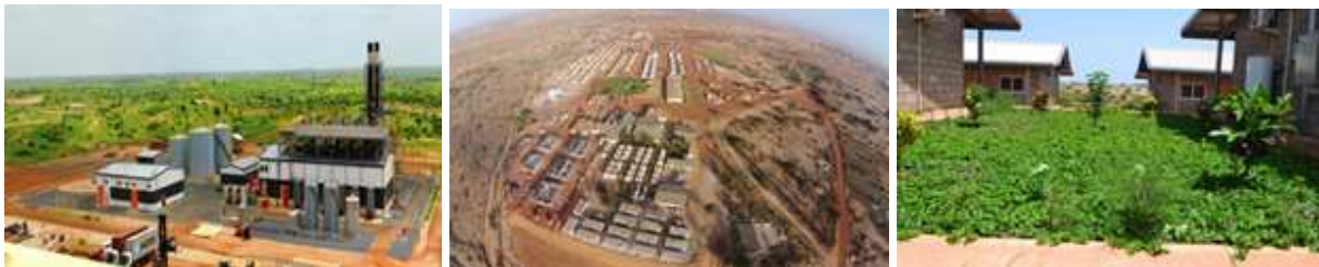
Figure 5, 6 & 7. Centrale électrique et Camp minier
