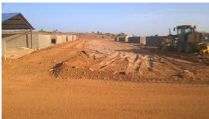
Figure 27. Construction nouvelle déchetterie
