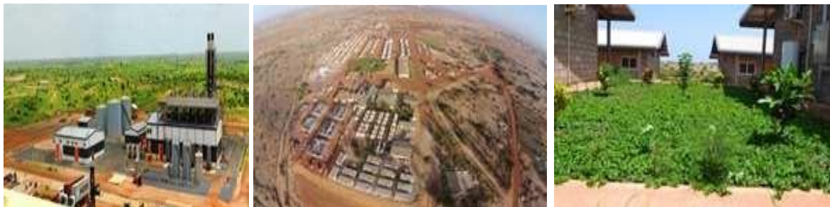
Figure 2. Centrale électrique et Camp minier
