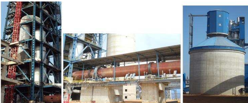
Photo 3 : Pré-calciateur (à gauche), Four rotatif (au centre) et Silo de clinker (à droite)
