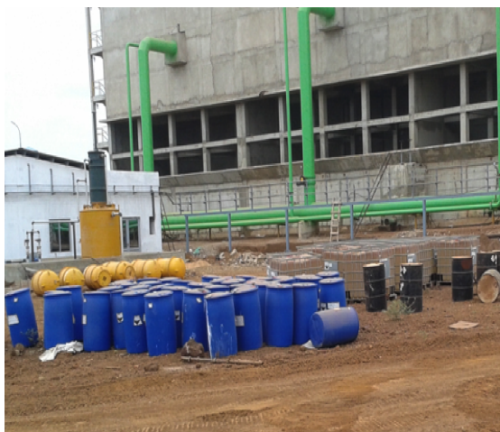
Photo 6 : Mode de stockage des produits chimiques de la centrale électrique
