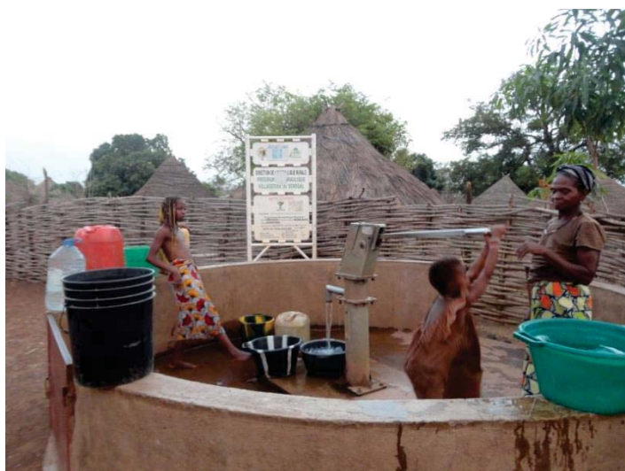
Photo 4.3.6 Forage à pompe manuelle
