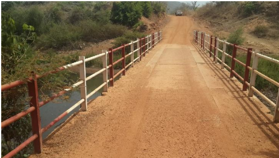
Photo 2.3.2 Vue de l'actuel pont permettant de franchir la rivière Koïla Kabé
