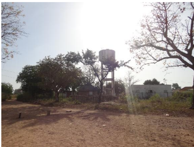
Photo 4.3.8 Forage motorisé avec château d'eau dans la Ville de Saraya
