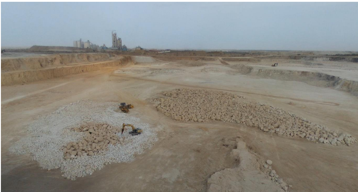
Figure 3: Traitement des blocs
