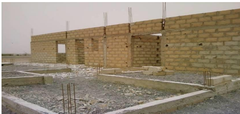
Photo 14 : Bâtiment en cours de construction dans le panneau P2
