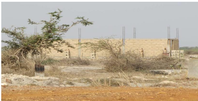
Photo 11 : Bâtiment en cours de construction dans le panneau P1
