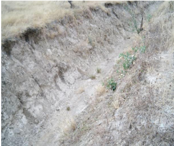
Photo 4: bassin de rétention des eaux de pluies
