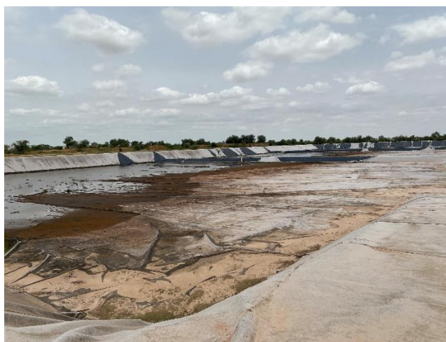
Photo 3: Trois alvéoles (de 1 hectare chacun) équipées de géomembrane, EDE-SEGU, Juillet 2024
