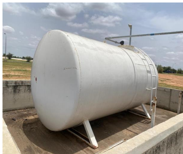
Photo 6: Aire de stockage d'une cuve à gasoil d'une capacité de 10 m3, EDE-SEGU, Juillet 2024
