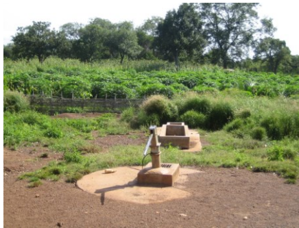
Plaque 2 : Puits d'eau souterraine installé par SGO au village de Faloumbo.
