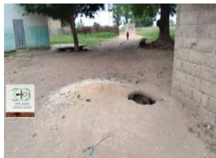
Fouille non balisée à Bandoulou Sèrène
