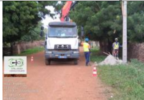
Respect des mesures de sécurité en hauteur
