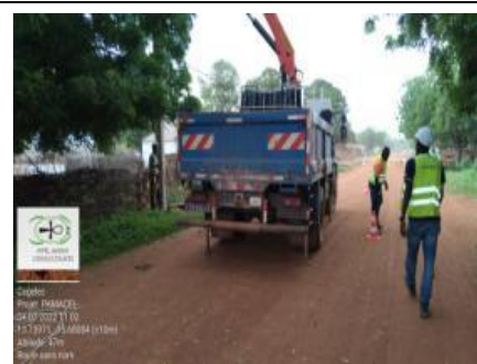
Balilage des zones de travaux
