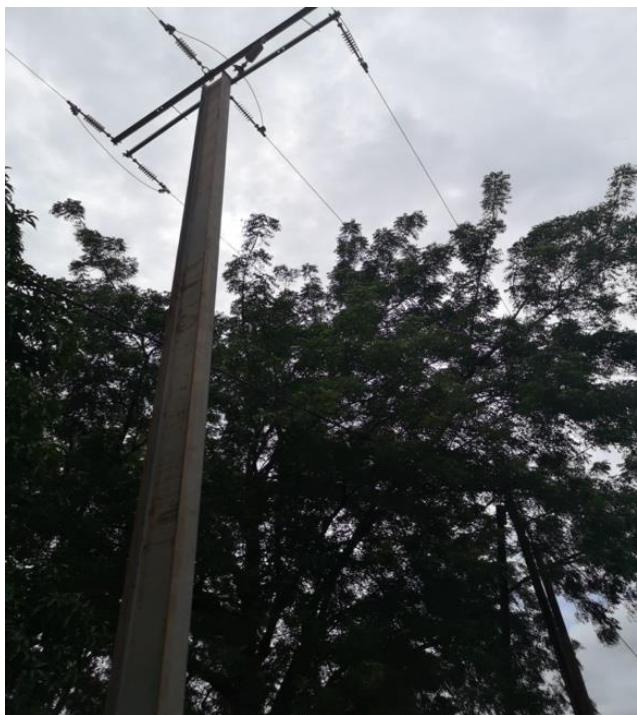
Photo 7: Ligne MT à l'intérieur d'un arbre
