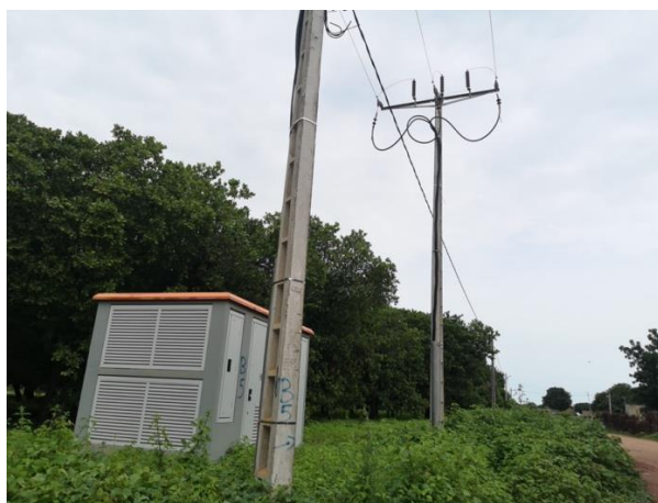
Photo 4: Ligne MT et poste de transformation
