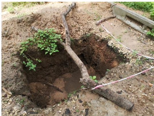
Photo 9 : Trou creusé pour l'implantation des poteaux et non remblayé (Risque d'accident)
