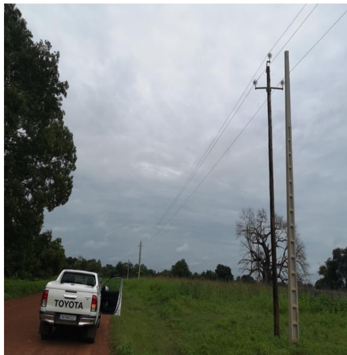
Photo 8: Remplacement des poteaux MT en bois
