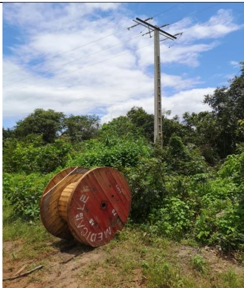
Photo 13 : Matériels éparpillés sur le chantier sans balisage
