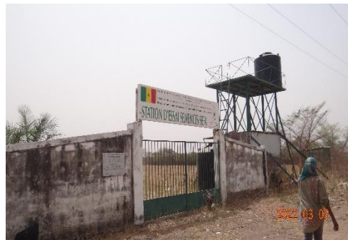
Photo 16 : Ligne MT surplombant une citerne d'eau localisée dans un domaine privé
