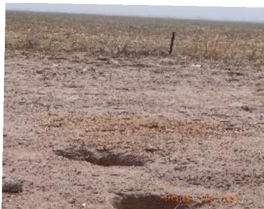
Photo 10 : Trou creusé pour l'implantation des poteaux et non remblayé (Risque d'accident)
