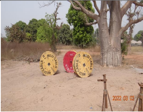
Photo 25 : Matériels éparpillés sur le chantier
