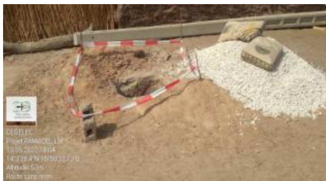
Photo 9 : Trou creusé pour l'implantation des poteaux et balisé
