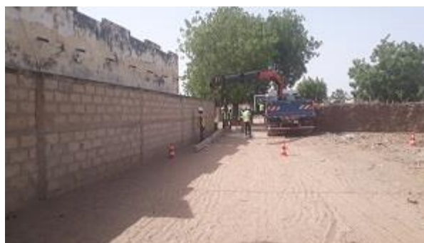
Photo 6 : balisage des zones de travaux
