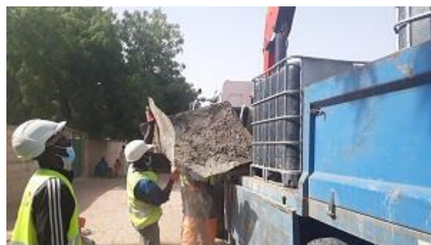
Photo 14 : plaque d'acier pour éviter la pollution du sol
