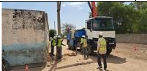
Manoeuvres d'implantation d'un poteau àThiamène Taba
