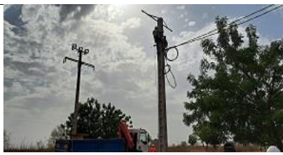
Montage d'armement pour le transformateur à Firmi
