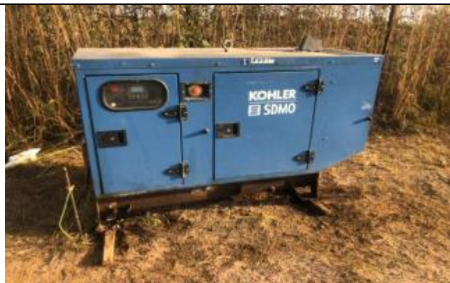
Absence de plateforme de rétention pour le Groupe électrogène (Non conforme)
